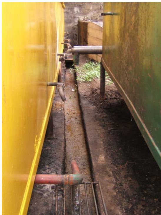
Fotografía No. 2. Descarga del efluente por medio de purgas a la canaleta de recolección. (Fuente: Gustavo Viteri, 11/01/2005)
