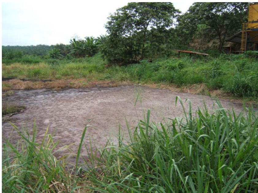
Fotografía No. 4. Piscina de tratamiento biológico totalmente colmatada. (Fuente: Gustavo Viteri, 11/01/2005)
